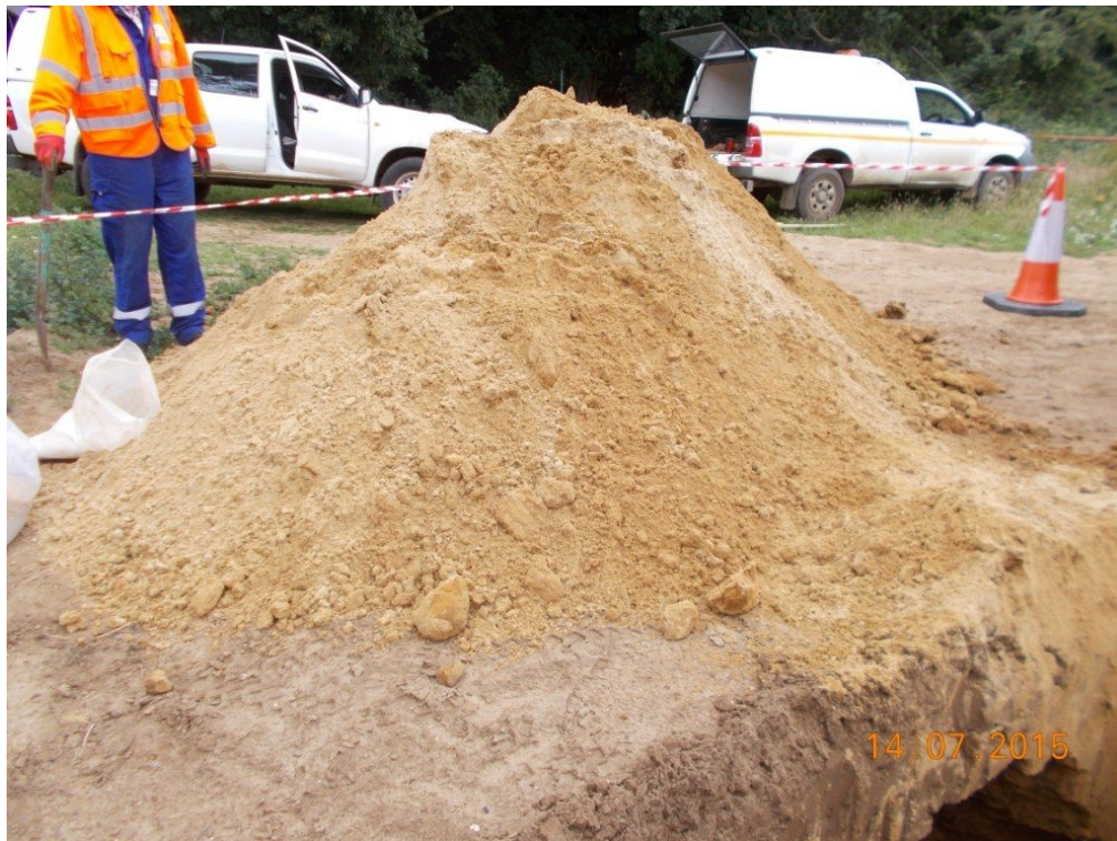
TP BP8 - SPOIL
