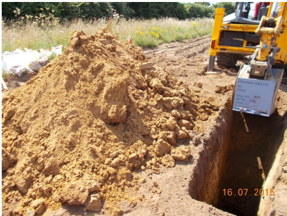
TP BP7 - SPOIL
