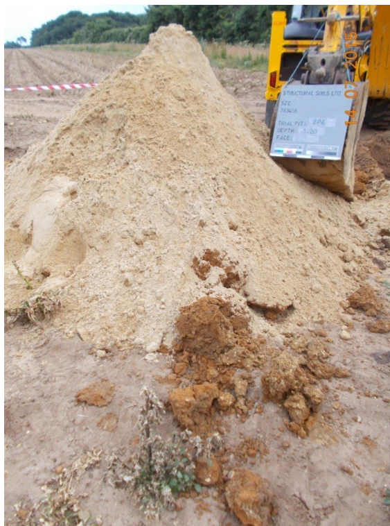
TP BP6 - SPOIL
