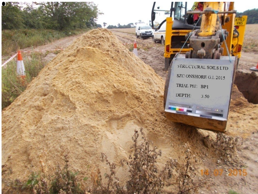
TP BP1 - SPOIL
